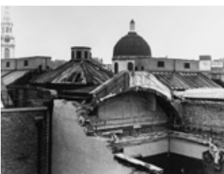
Il tetto della National Gallery danneggiato dai bombardamenti
