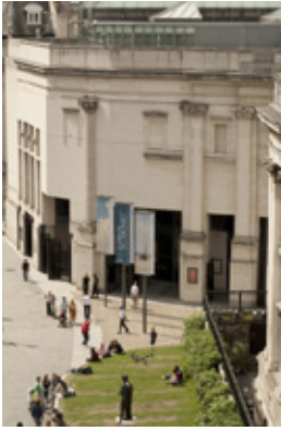
L'Ala Sainsbury vista dall'esterno
